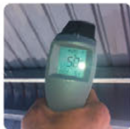
อุณหภูมิใต้หลังคาเหล็ก ที่ไม่ฉนวน
